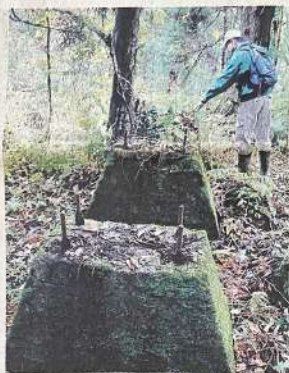
ホルトが突き出た構造物の土台
