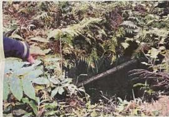
掘削の穴はいまも不気味な口を開けている
